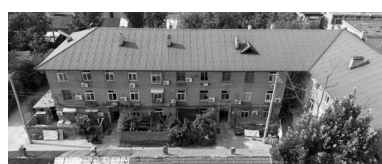
「1956年型」 第III期計画に幅広く建設され、「標準設計住宅」の思想に基づいて設計・建設された一番代表的なプランである。市内にある同時期の他社（つまり国営企業）の社宅地に類似する集合住宅も見られる。同じ図面で施工され、会社ごとに細部の意匠だけ変更した可能性が高いと見られる。
