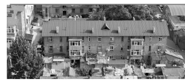
「1959年型」は第IV期計画以降に建設された住棟で、建設時期が遅いものの、各戸の性能・機能水準はさらに低く設定されたと見られる。各個室の面積はさらに縮小し、専用のトイレも無くなった。
